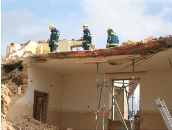
Deckenabstützung mit Stützturm
